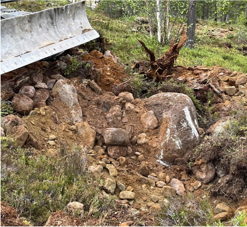
Figur 4.5. Fotografi på blockförekomsten i provgrop 23W03.
