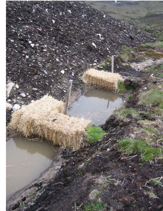
Halmbalar förhindrar slamtransport och grumling vid vindkraftverk i Skottland
